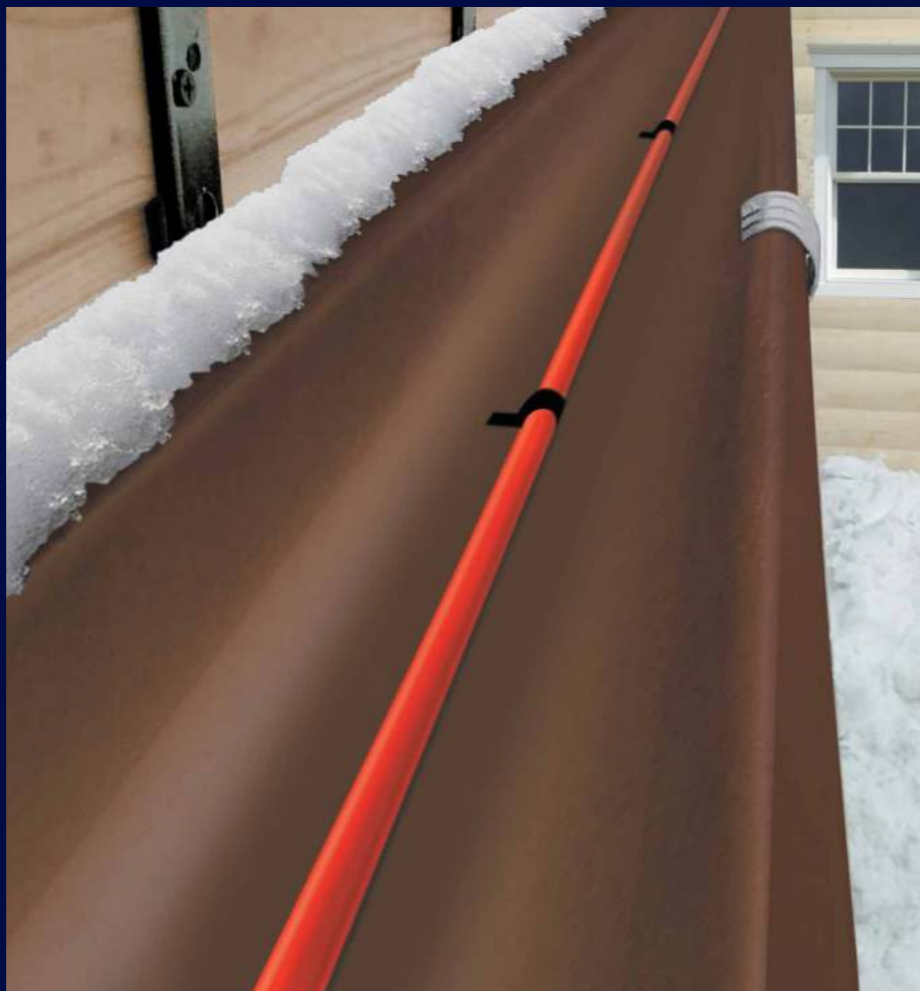
Вариант установки нагревательного кабеля в водосточных желобах
